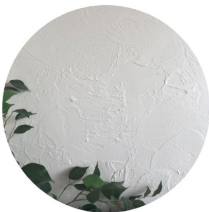
内装壁材・琉球の塗り壁
