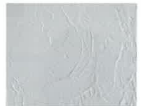
琉球の塗壁(サンゴの塗壁)
